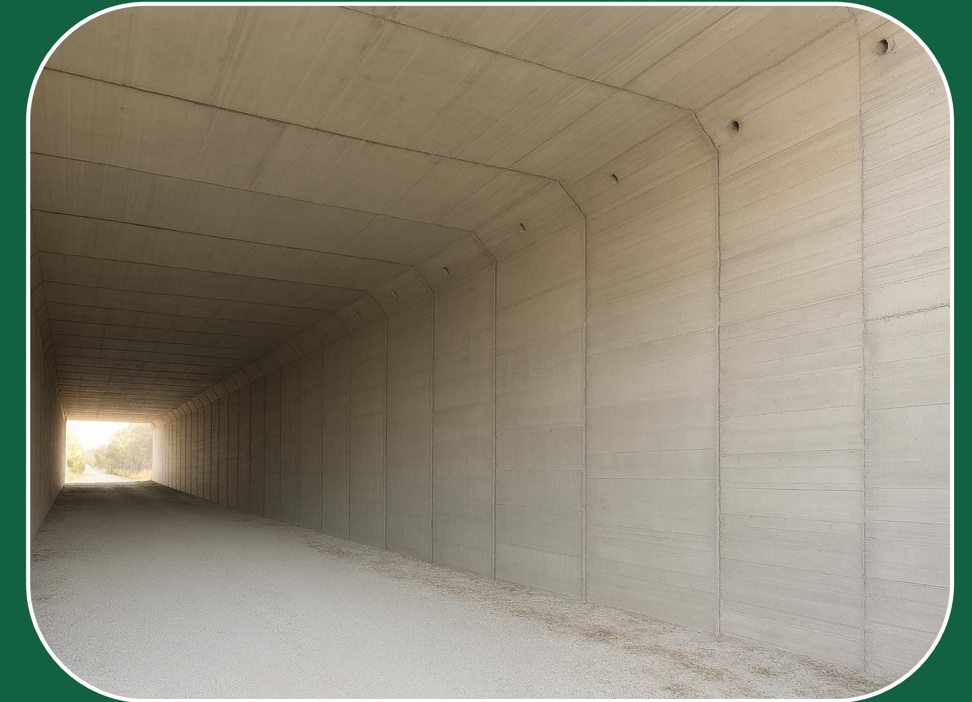
Paint Over the Graffiti.
